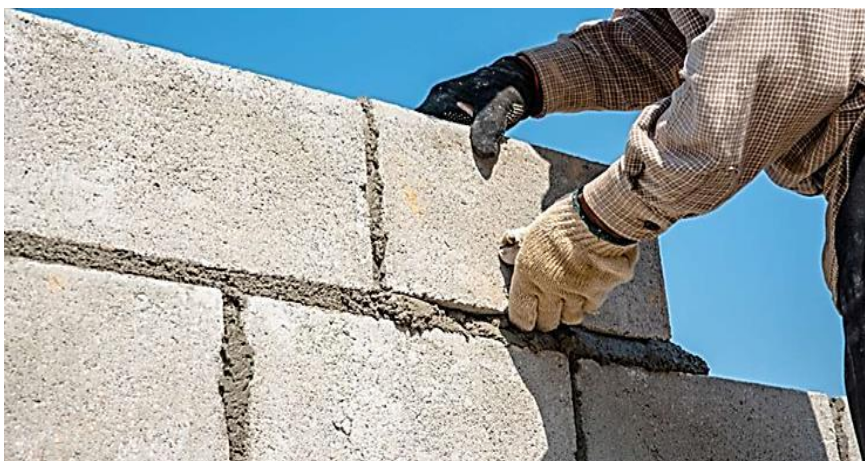
Figure II.4 : Pose de mortier de hourdage [17].
