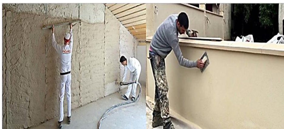
Figure II.5 : Enduits isolants et enduits de façade [17].
