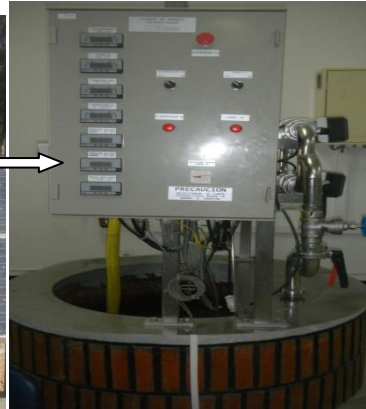
Puits et armoire de visualisation
