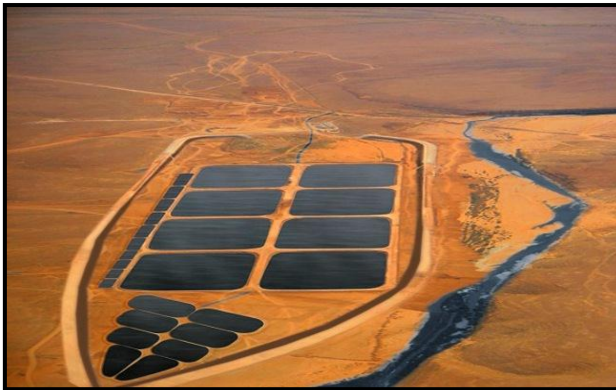
Figure III.1 : la step d'épuration d'ATTEUF
