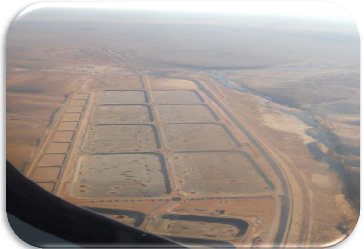
figure 19 : Autre vue de la STEP en construction (23 février 2012)
