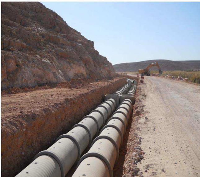
Figure 07 : Construction du collecteur principal en 19 février 2012
