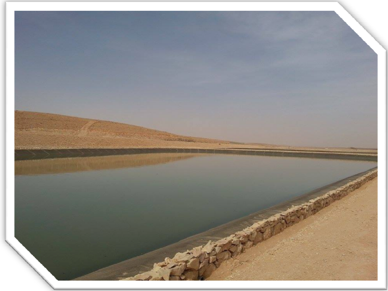
Figure 38 : bassin étangs anaérobies
