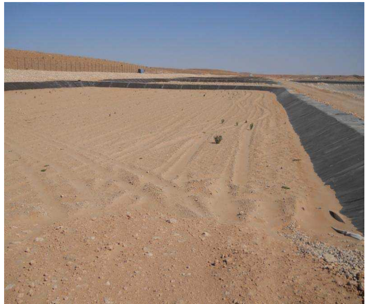
Figure 39 : lit de séchage
