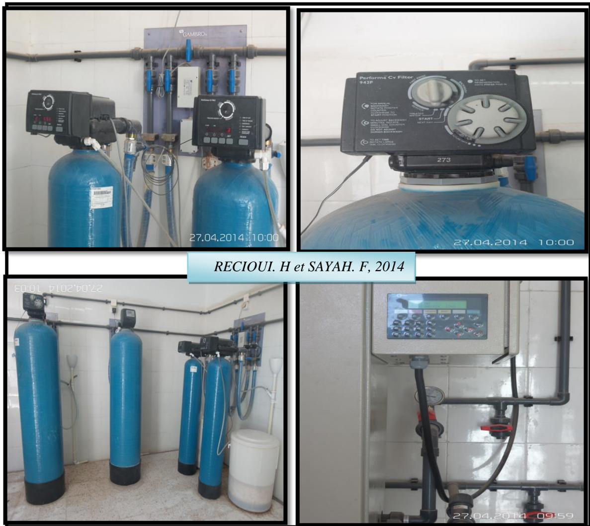
Figure.05. Quelques composants de la station de traitement de l'eau pour l'hémodialyse
