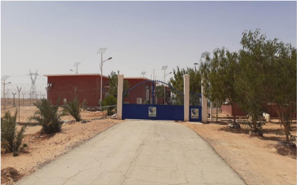
Figure III-1 : Entrée de la centrale photovoltaïque de ZAOUJET EL-KOUNTA.
