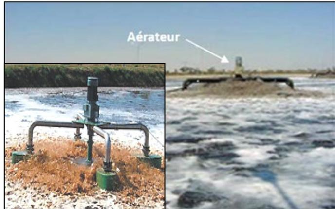
**Fig. 3.7 : Lagunage aérées (aérateurs de surface amarrés) [29];[4].**
