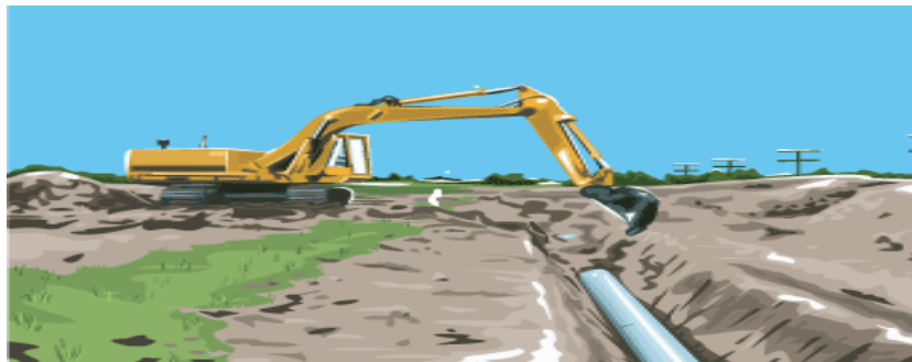
FIG IV-2 : REMBLAI DES TRANCHEES
