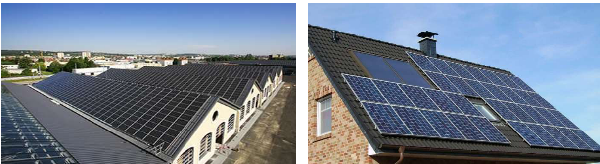
Figure 3.4 : Intégration en " toiture "
