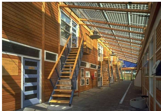
Figure 3.2 : Intégration de type " véranda " [35]
