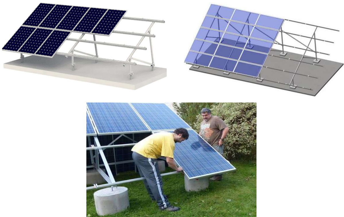
Figure 3.9 : Montage des supports de modules PV
