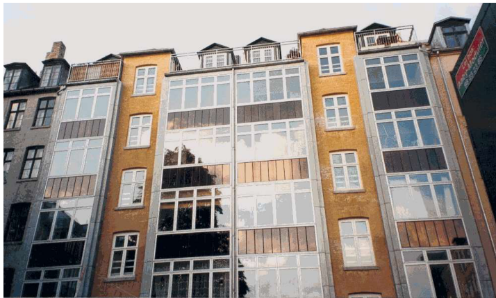
Figure 3.7 : Intégration en allège de vitrage, après rénovation de façade
