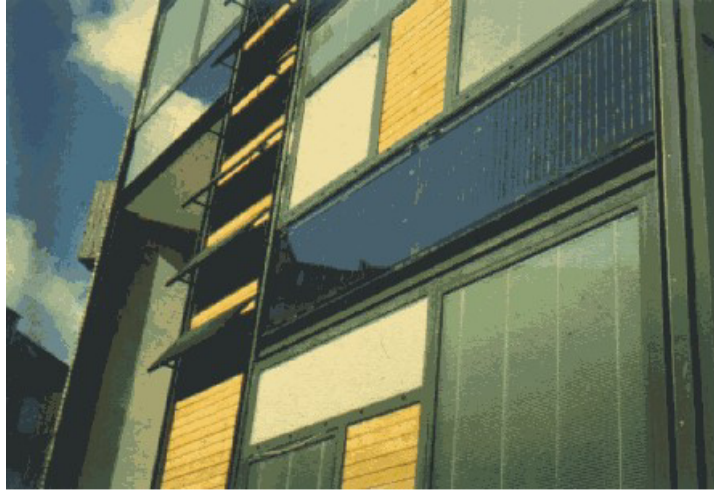
Figure 3.6 : Intégration en allège de balcon vitré
