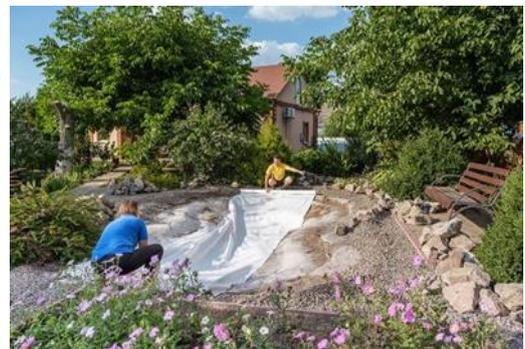
**Figure II.2 :**Les géotextiles
