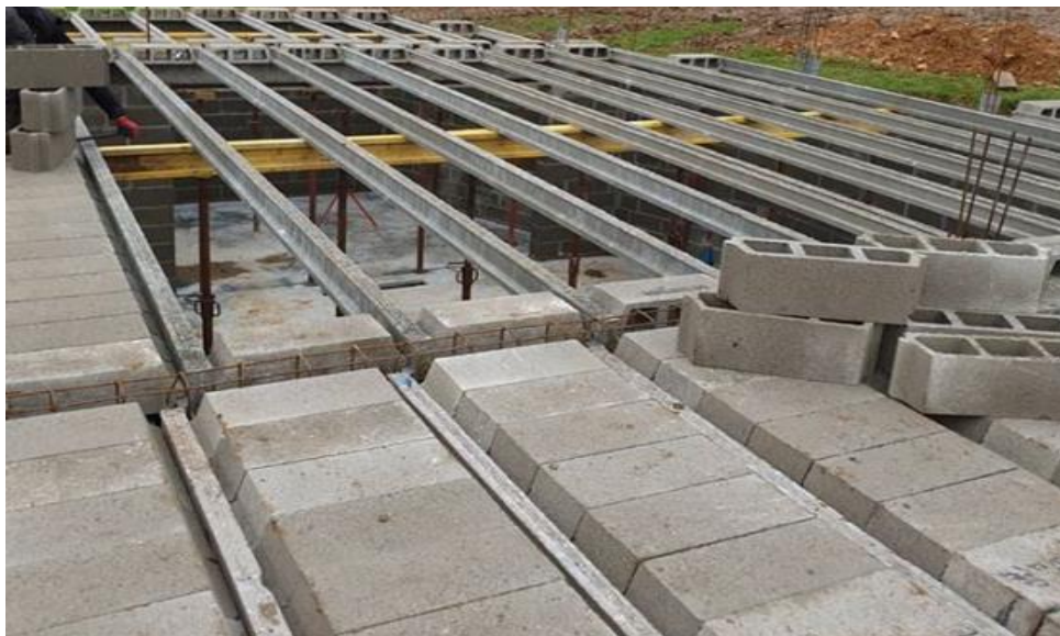
Figure. II- 13 : Plancher hourdi en béton. (DERRADJI, 2022)
