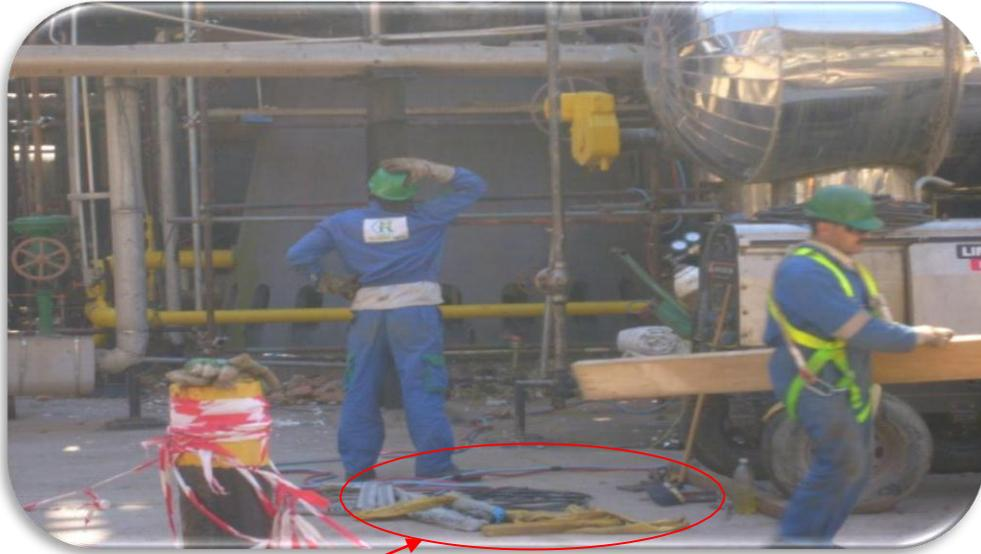
Encombrement des lieux de travail (risque de chute en plein pied) + présence de fils électriques (risque d'électrocution et d'électrisation)
