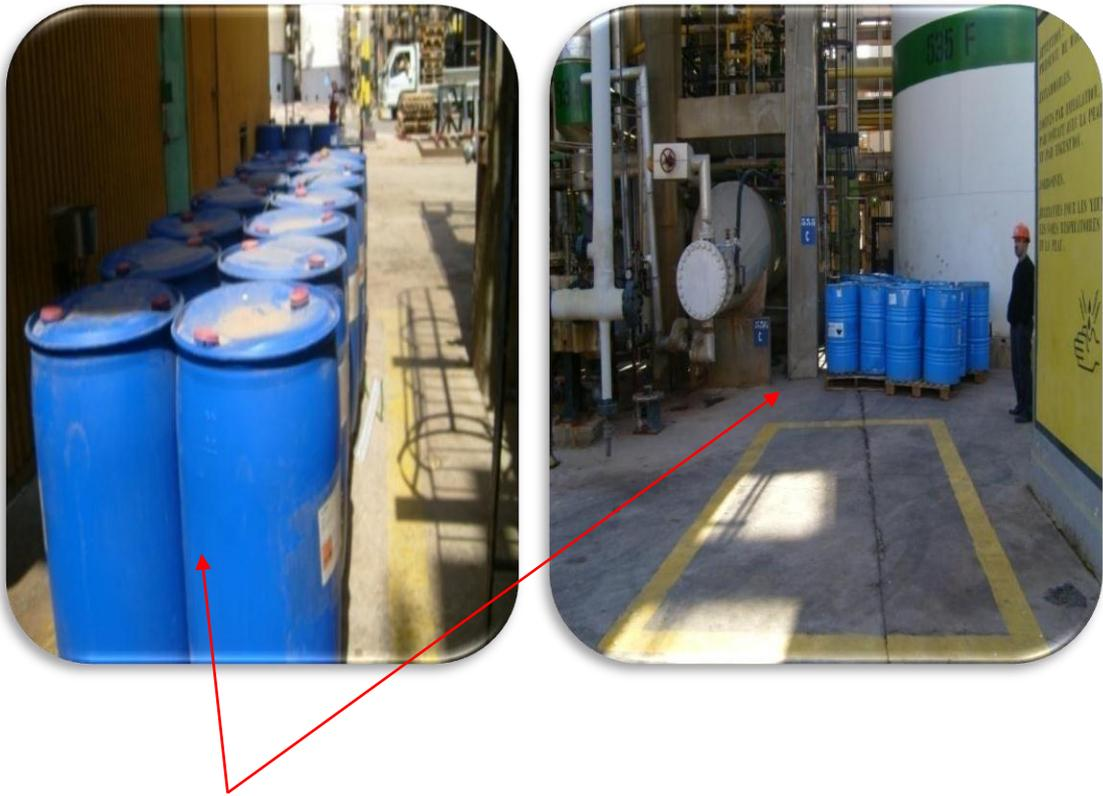
Encombrement des lieux de travail par les futs de MEA (Monoéthanolamine) dans la section de décarbonatation. En cas ou un accident est survenu, les voies de dégagement sont bloqués et donc les employés aurant des diffucultés à quitter le lieu de travail et à secourir les victimes.
