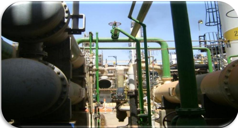
La plupart des vannes sont inaccessibles, dans l'étape de la mise à disposition d'un équipement (isolement de l'alimentation en gaz naturel), l'employé trouve des difficultés à accéder à ces vannes.
