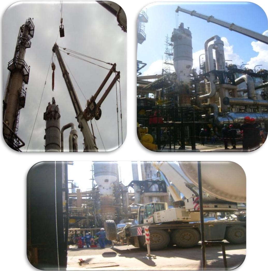
**Figure II.3 :**Levage mécanique (avec grue)
