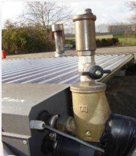
Figure 20 : Purgeur manuel au point haut du circuit primaire
