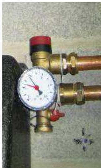
Figure17 : Manomètre indiquant la pression du circuit primaire
