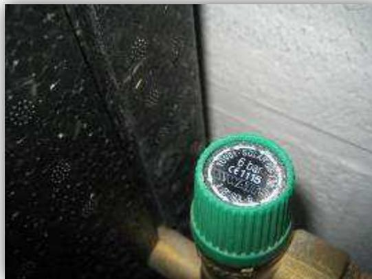
Figure 19 : Soupape de sécurité
