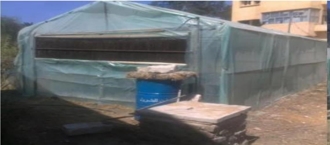
Figure 2 - 12: Système de refroidissement par évaporation à ventilateur [23].
