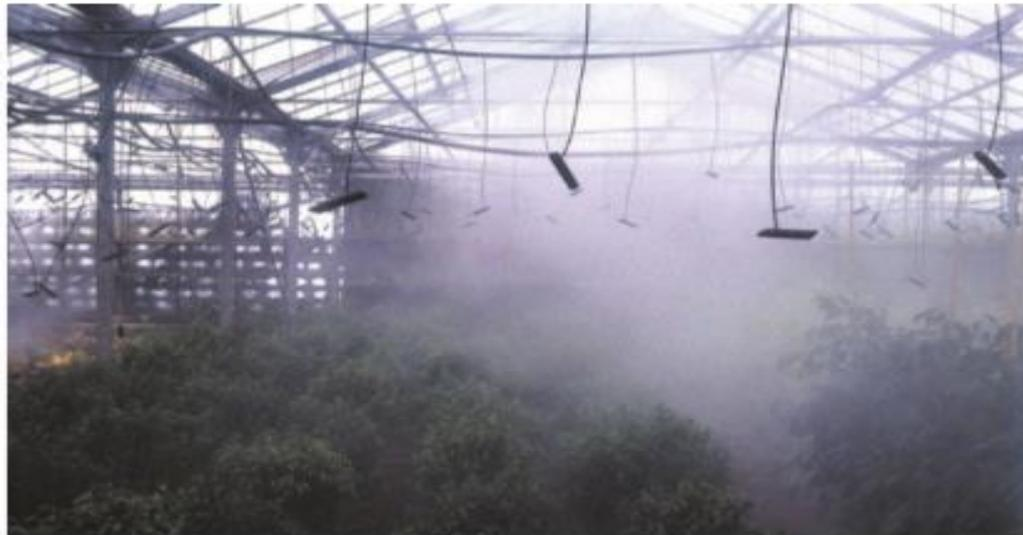
Figure 1 - 9: Système de brouillard [15]
