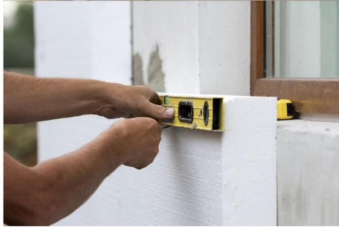
Figure I.11 : Le polystyrène expansé. [27].
