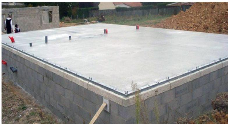
Figure II.10 : Le plancher en béton. [70]
