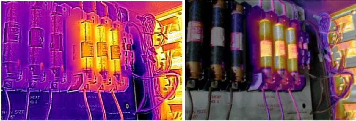
Figure III.10: Inspection thermique d'un tableau électrique intérieur (industriel)
