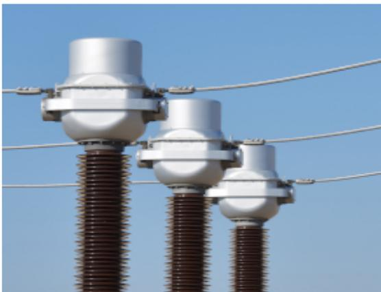
**Figure I. 7:**Transformateurs de courant
