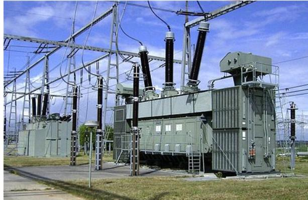
**Figure I.4:** Transformateur de puissance dans un poste électrique
