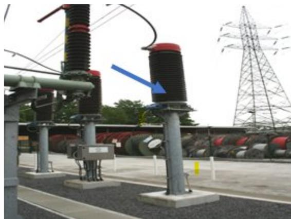
**Figure I.8 :** Transformateurs de tension
