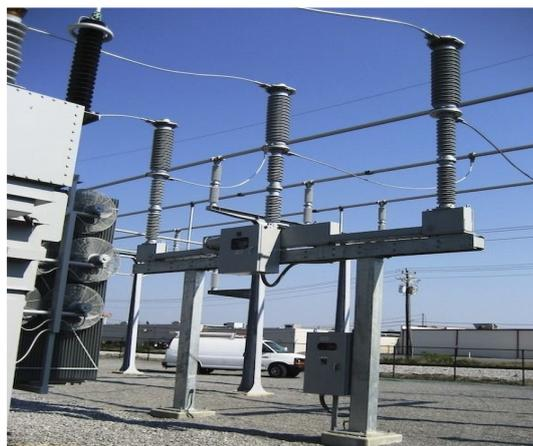
**Figure I. 5:** Disjoncteurs haute tension
