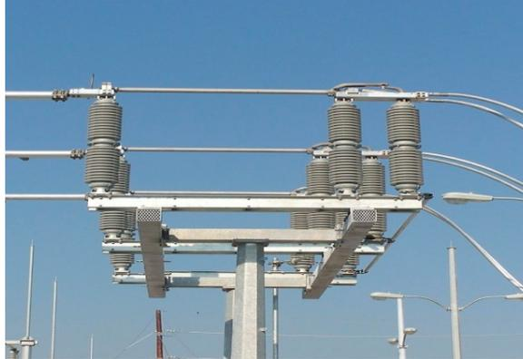
**Figure I. 6:**Sectionneurs haute tension
