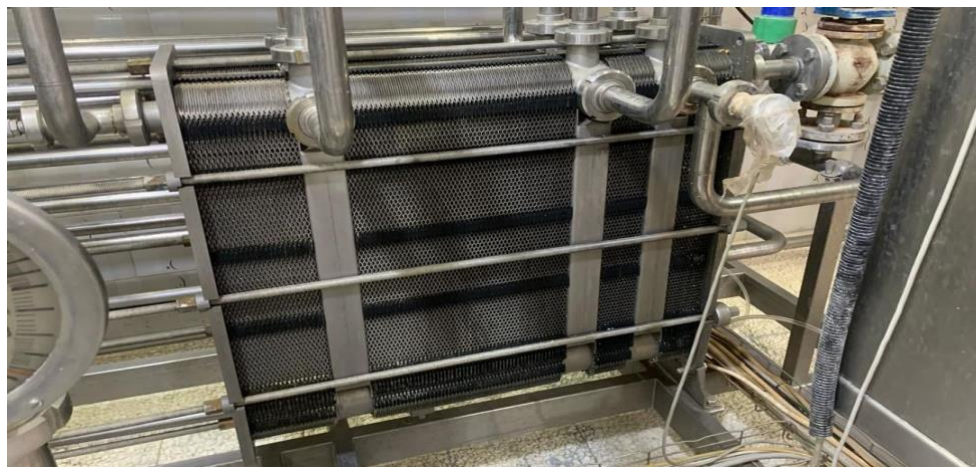
Fig05 : Échangeur thermique a plaque.
