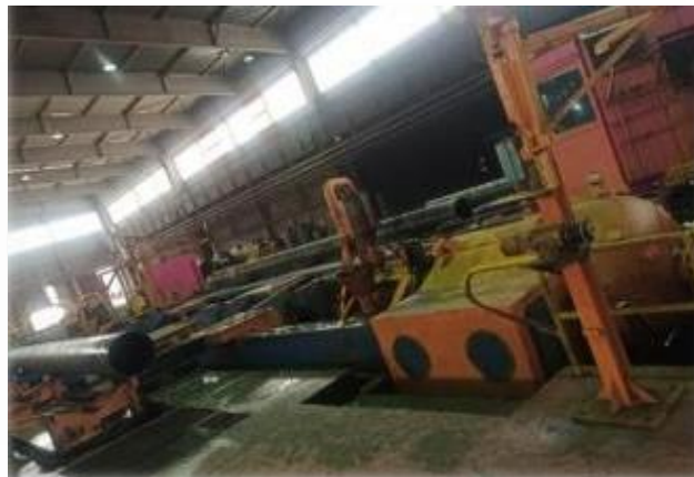
Figure.I.7: Banc d'essai hydrostatique
