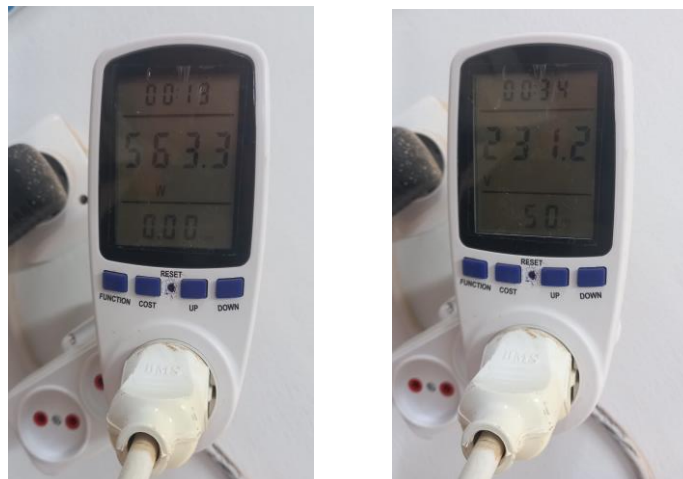
Figure 2.10 : Photo du compteur numérique de puissance
