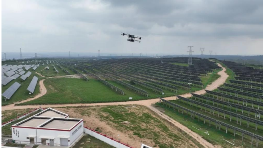
Figure I.4 : Système de nettoyage robotisé et automatisé pour l'élimination de la poussière sur les panneaux photovoltaïques [15]
