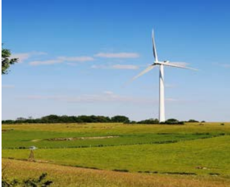
Fig. 4. Éolienne à axe Horizontal. Nordex N80 / N90
