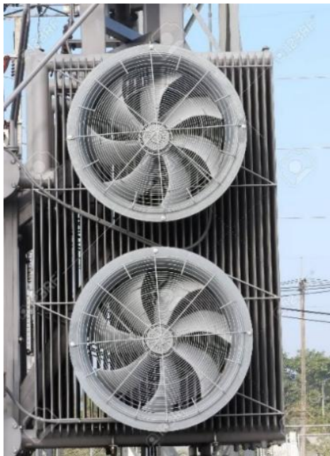
Figure I.28 : Ventilateurs (refroidissement forcé par air)
