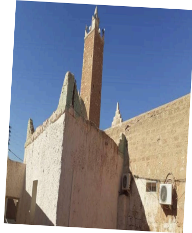
مسجد القصر القديم
