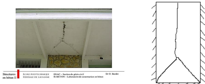
Fig.24 : Exemple des lignes de rupture d'une dalle [12].
