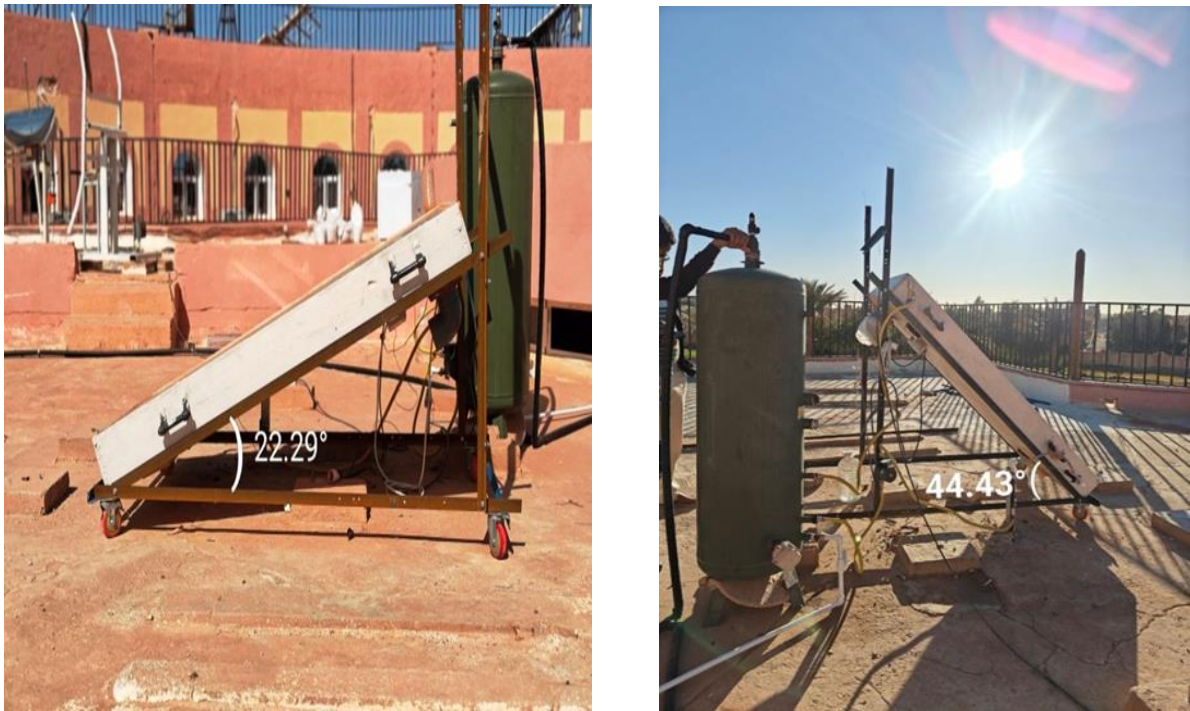
Figure 2-2 : photos explique l'angle d'inclinaison optimal du capteur solaire pour les mois février (à droite) et avril (à gauche).
