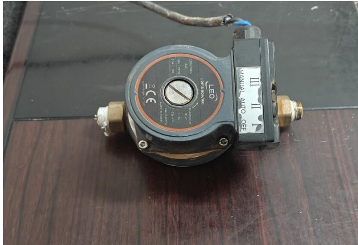
Figure 1-10 : la pompe de circulation.
