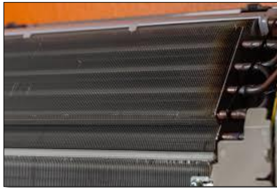
Figure 14 : Évaporateur à ailettes de l'unité intérieure[19] .
