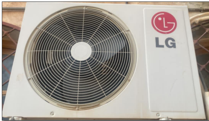
Figure 15 : Unité extérieure du système de climatisation étudié.
