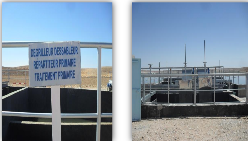
Figure II.22 Dégrilleur - Dessableur
