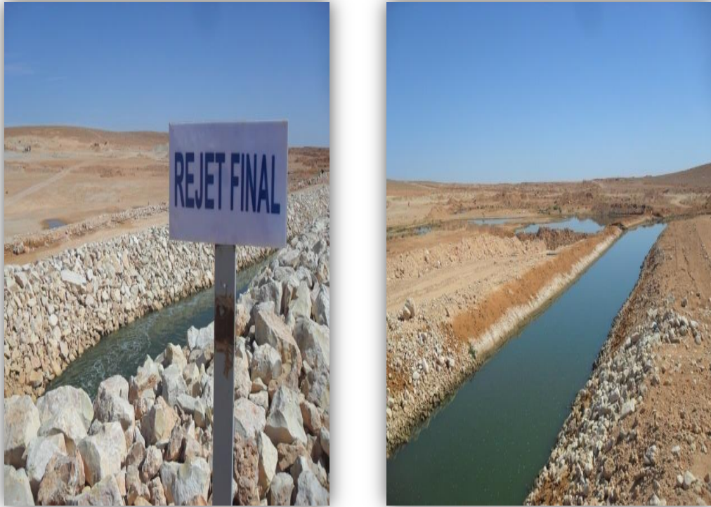
Figure II.26 Rejet final vers oued M'Zab
