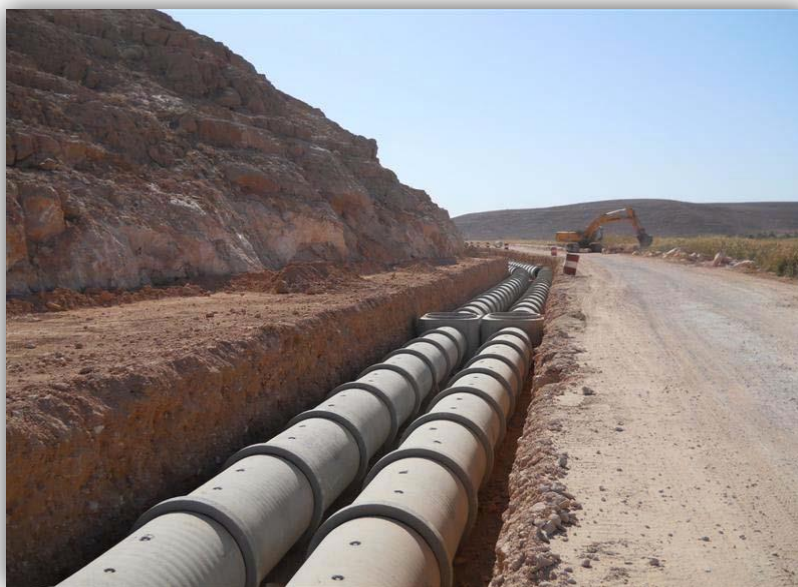
Figure II.21 Collecteurs d'amenée des eaux usées
