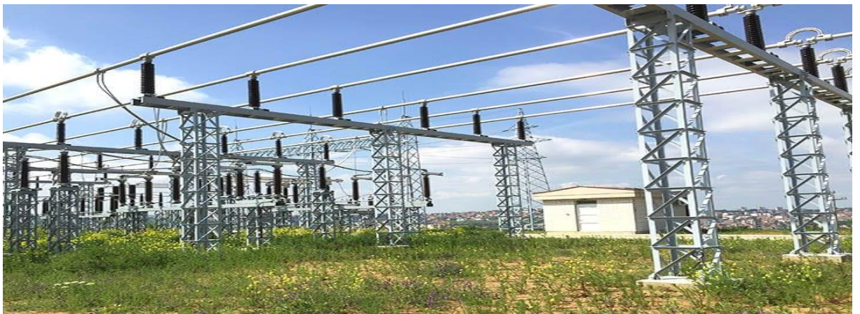
Figure I.4: Jeux de barres en tube AGS.
