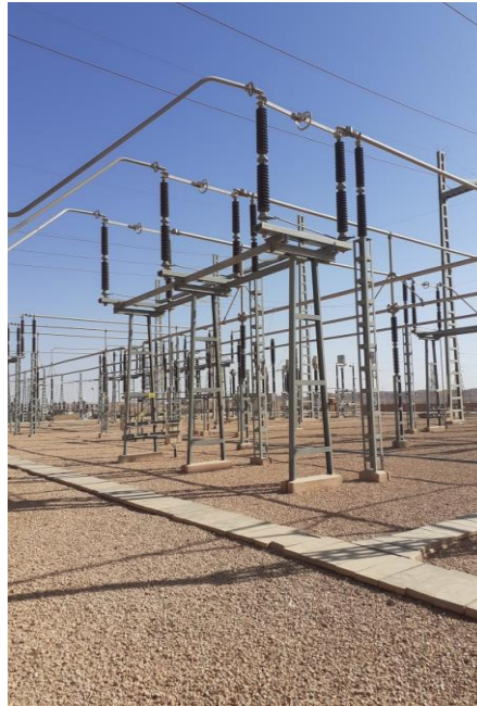
Figure I.5: sectionnaire de barre (de sectionnement).
