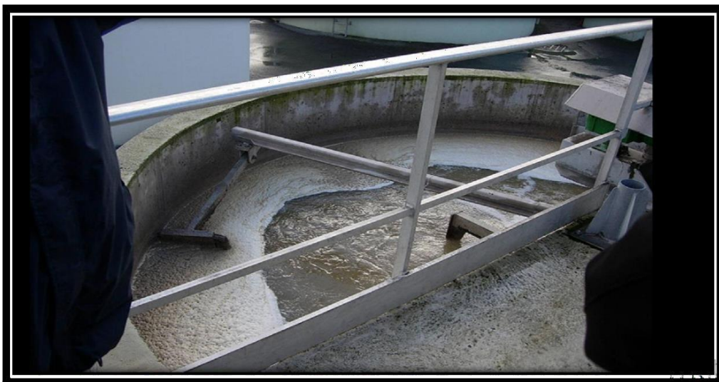
Figure I. 3 : Schéma représente Le dégraissage-déshuilage (Fecih 2012).
