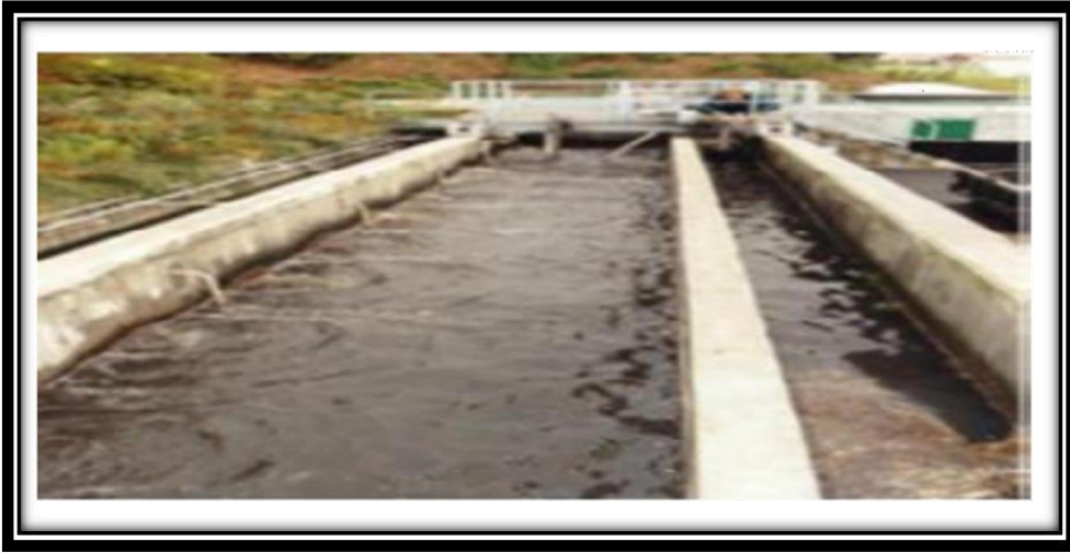
Figure I. 2 : Schéma d'un dessablage (Mahdjar 2016).
