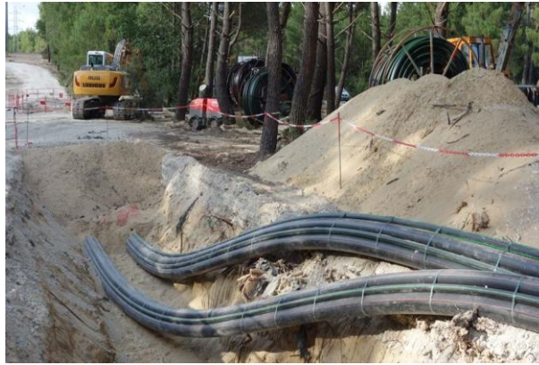
Figure I.2 Les câbles souterrains [5].
