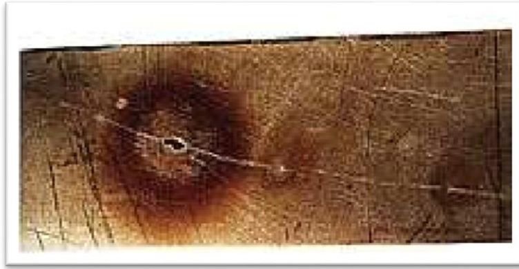
Figure (I.3) : Corrosion par piqûres
