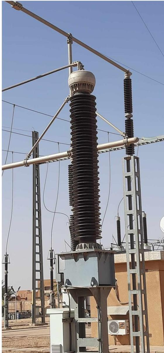
Figure II-15 : Transformateurs de tension
