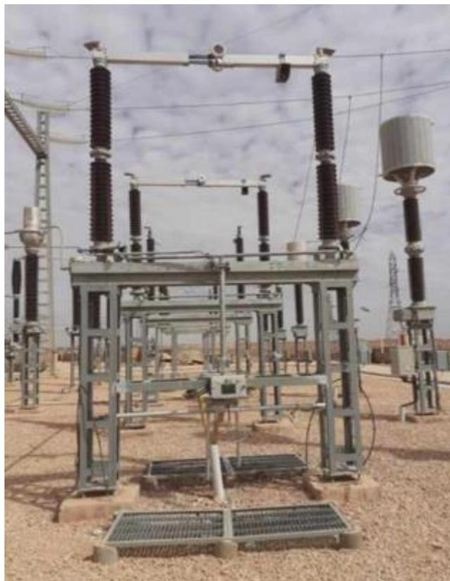
Figure II-11 : Sectionner de ligne et mise à la terre
