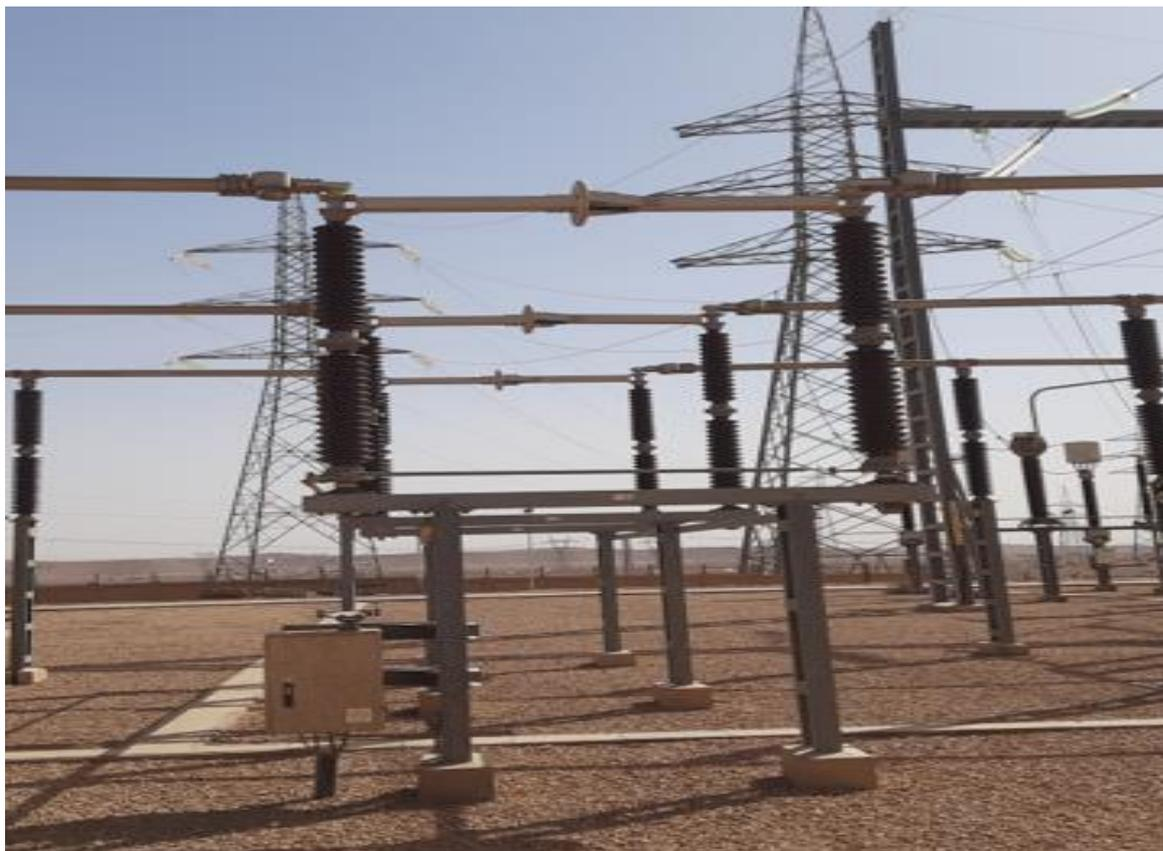
Figure II-10 : Sectionner de barre
