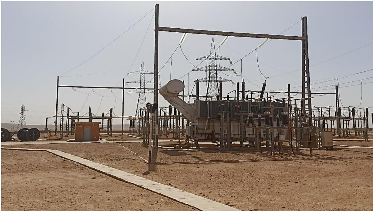
Figure II-8 : Etage 220 KV d'un poste de transformation électrique
