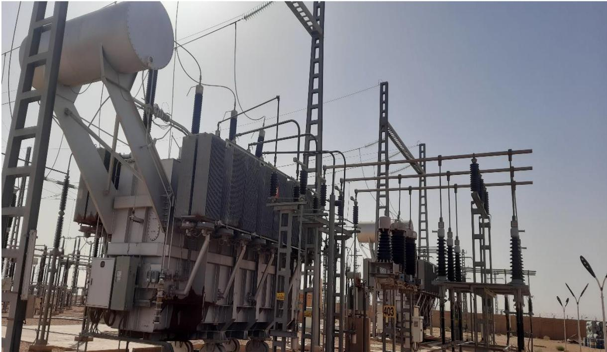
Figure II-13 : Transformateur de puissance
