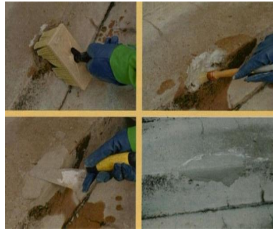
Figure 83 : Remplir les fissures avec du mortier époxy. [42]
