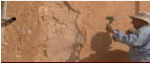
↓ Figure 114 : Décapage
