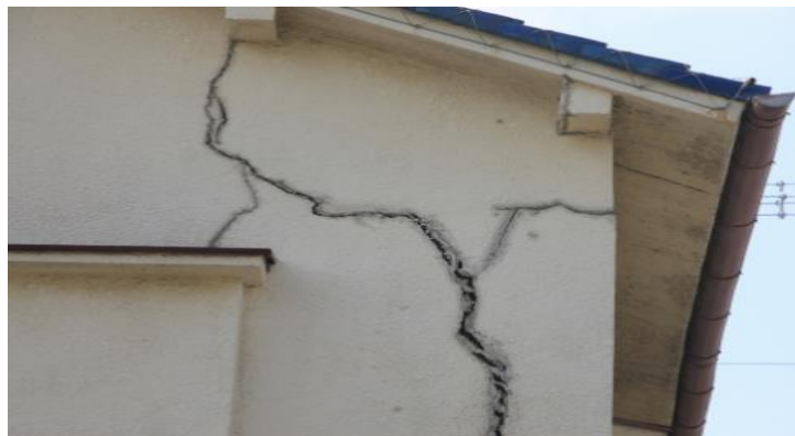
Figure 77 : une lézarde de plusieurs centimètres de largeur. [52]
