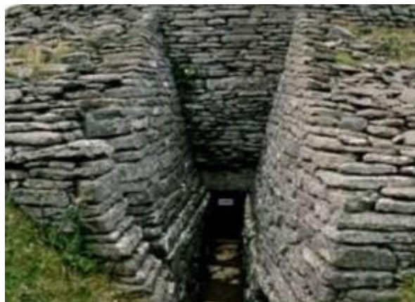
Figure 02 : cas d'une ancienne habitation en pierre [4]
