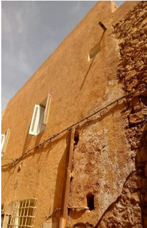
Figure 111 : cristallisation des sels sur la surface « maison 1 » [20]
