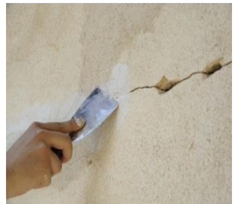
Figure 81 : Répare les fissures par enduit horizontales [40]
