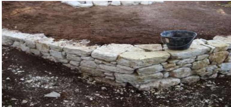
Figure 61 : mur en pierre à double rangée [11]
