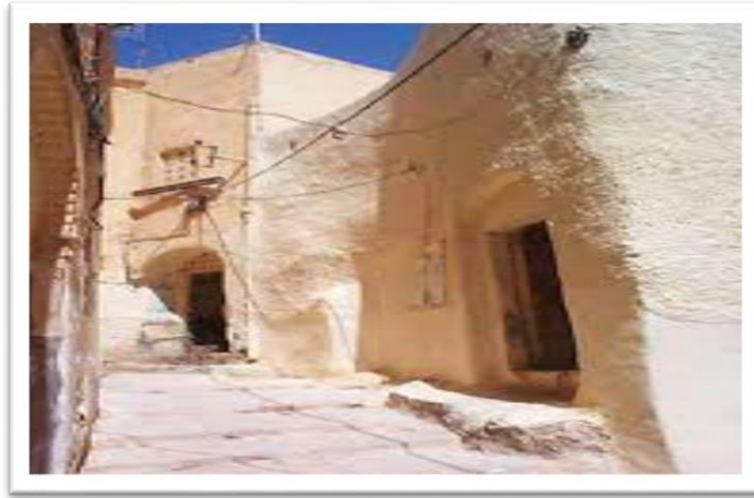
Figure30 : façade d'une maison mozabite, [26]
