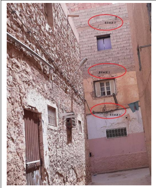
Figure 139 : danger d'effondrement [20]
