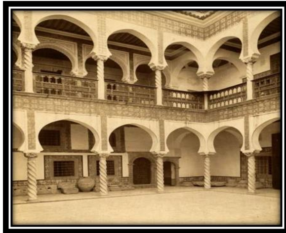
Figure 07 : Maison de la kasbah [11]
