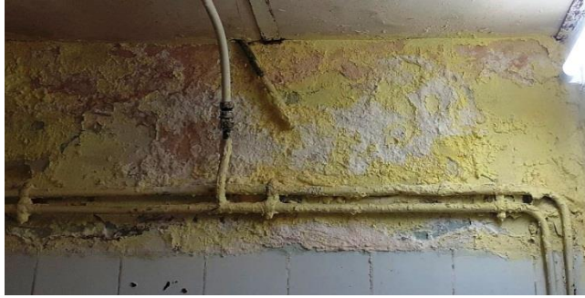
Figure 87 : dégradation de plancher de maison de Ghardaïa [20]
