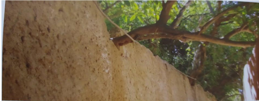
Figure 95 : les effets de la végétation branchent d'arbres et racines. [44]
