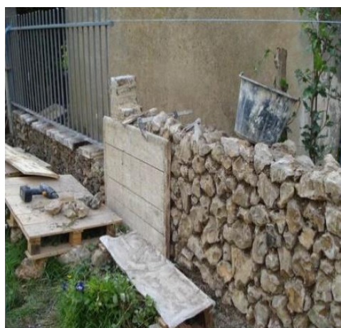
Figure 60 : mur à un seul ranger [11]
