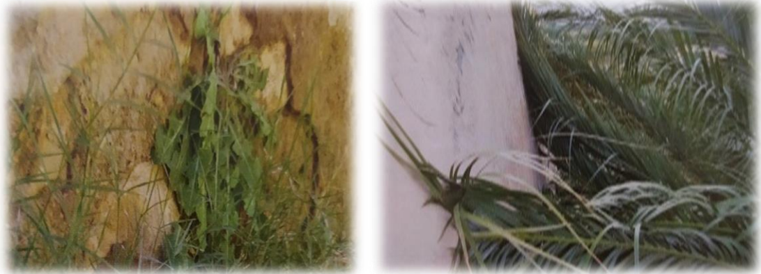
Figure 91 : Des palmes et des branches d'arbres dont la friction avec les façades [44]
