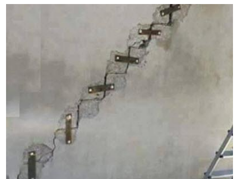
Figure 82 : réparer les fissures inclinées. [40]
