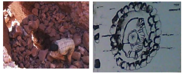
Figure 49 : présente la pose des premières pierres à l'intérieure du four [29]
