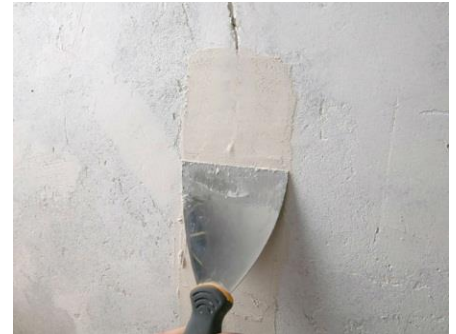
Figure 80 : Répare les fissures par enduit verticales [39]
