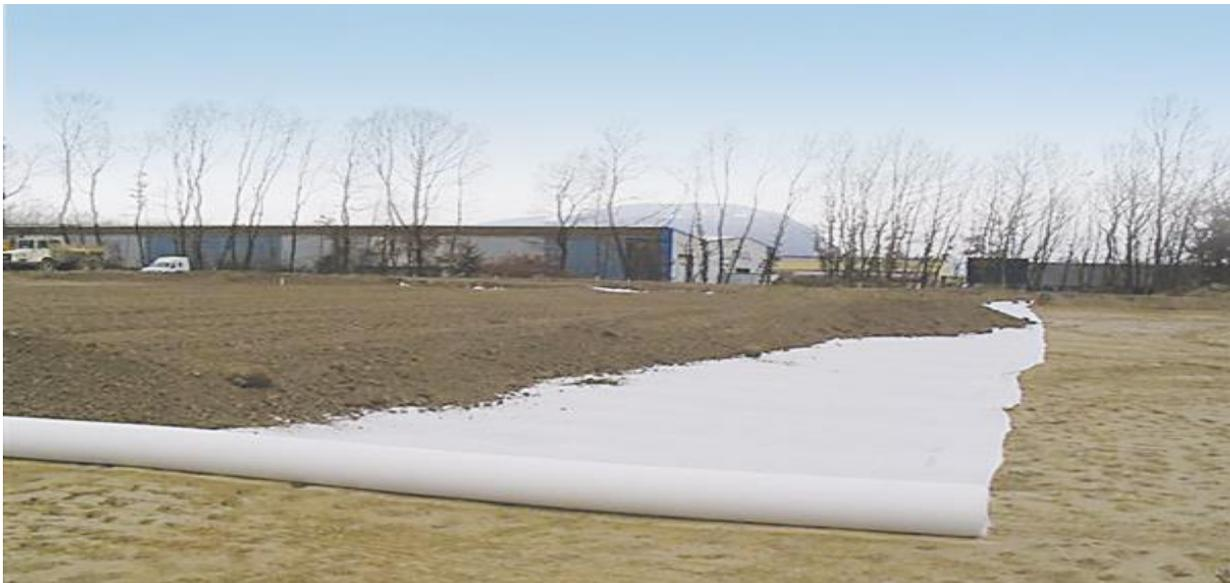
**Figure II.1** : Les géotextiles.
