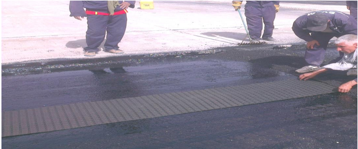
Figure II10 Mise en place de la Géogrille dans l'aérodrome EL MENIA
