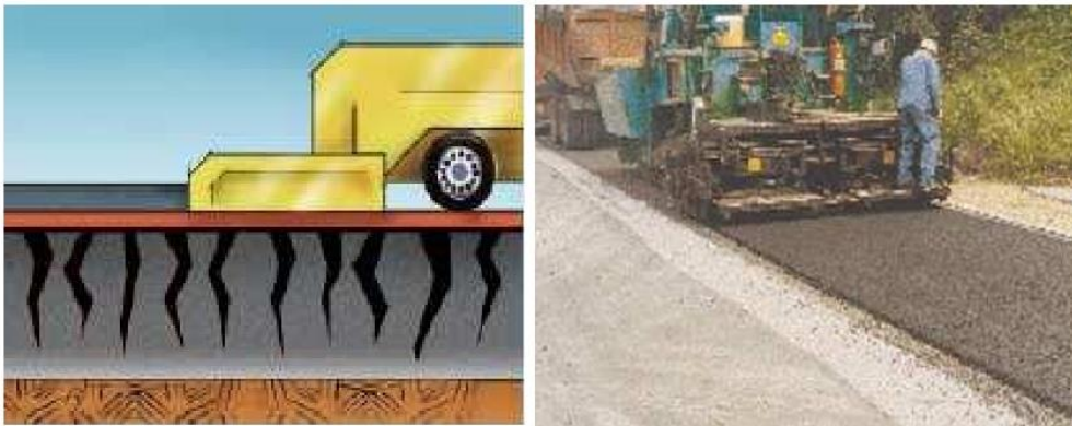
Figure II- 13 Mise en place de recouvrement bitumineux
