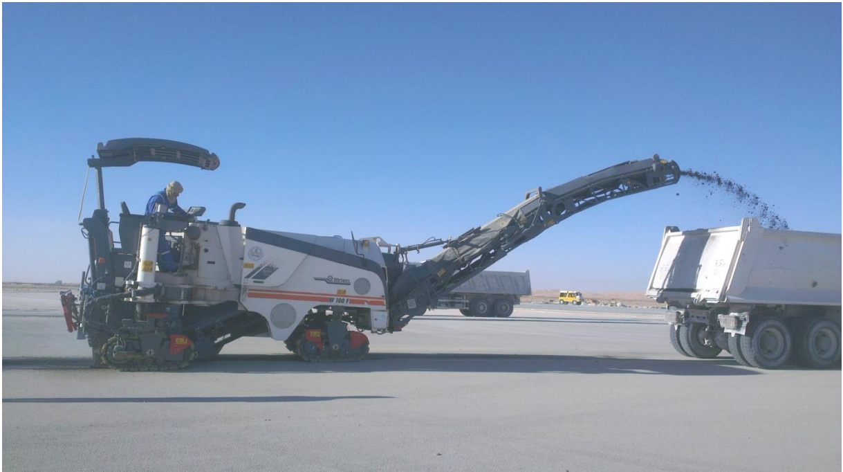
FigureII- 09 Fraisage la bande centrale sur 30 m de largeur de piste principale de l'aérodrome EL MENIA.
