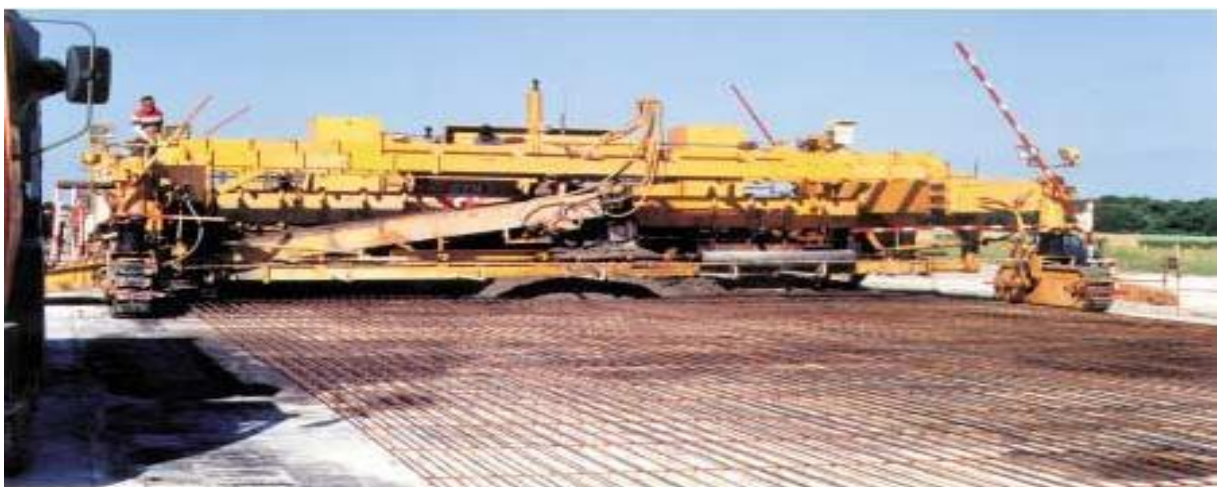
Photo V.II .3- Aéroport de Lorient-Lann Bihoué : reconstruction de la piste en B.A.C.
