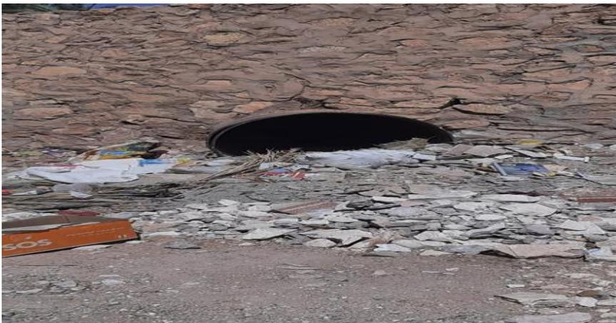
Figure 20 : **Fermer les drains avec des ordures** (prise par l'étudiant)
