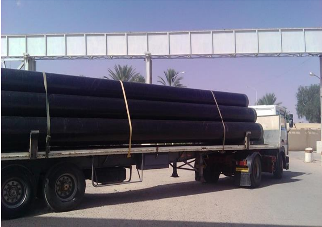
Photo N° 13 : Transports des tubes par tubes par camion SNTR
