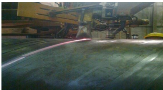
Machine à soudée Extérieurement.
