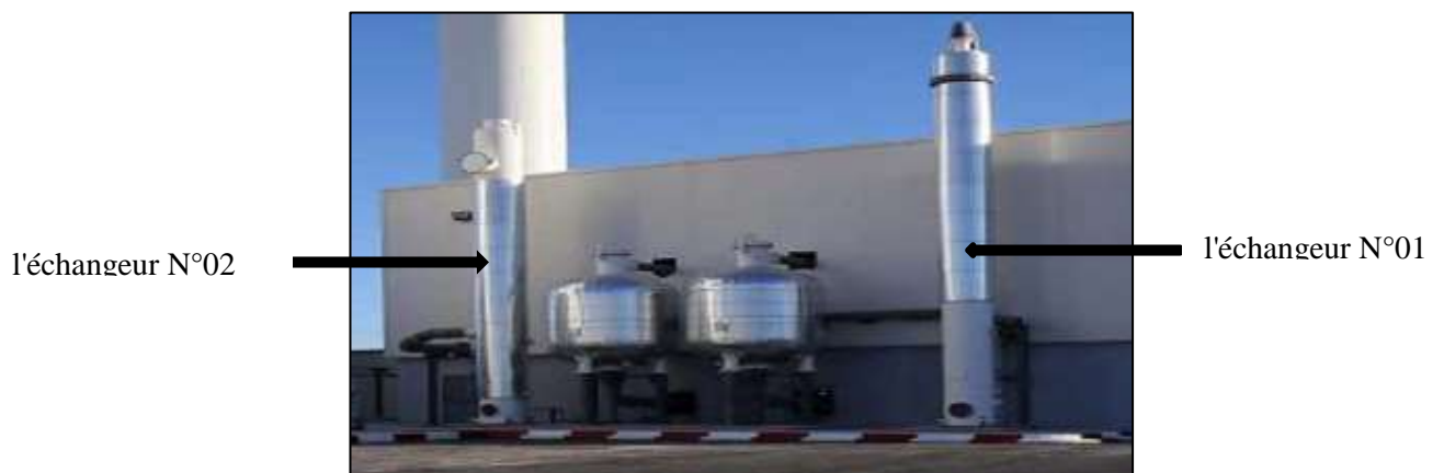
Figure I.6: Unité de l'échangeur.
