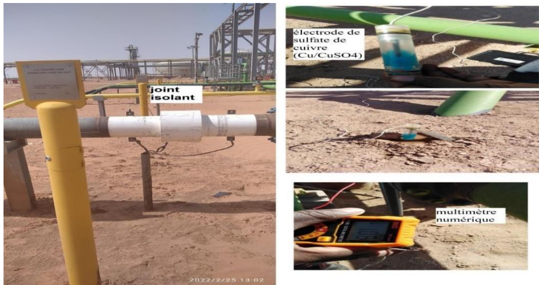
Photo III-11 : Méthode de mesure de potentiel de la protection cathodique et l'efficacité de joint isolant
