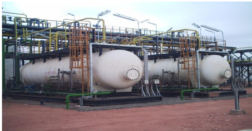
Photo I-2: Séparateurs tri-phasique CPF
