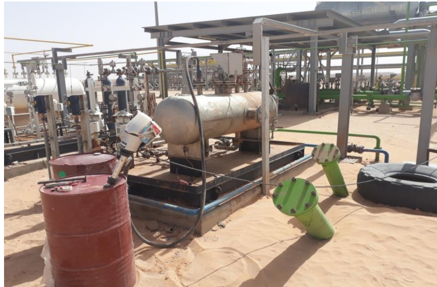
Photo II-4 : Unité d'injection chimique FPF OTRA (TOUAT HUILE ADRAR)
