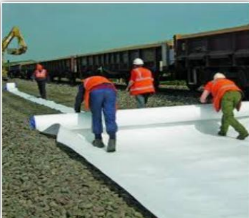
Figure N° 13: Le techniques de la stabilisation par géotextiles
