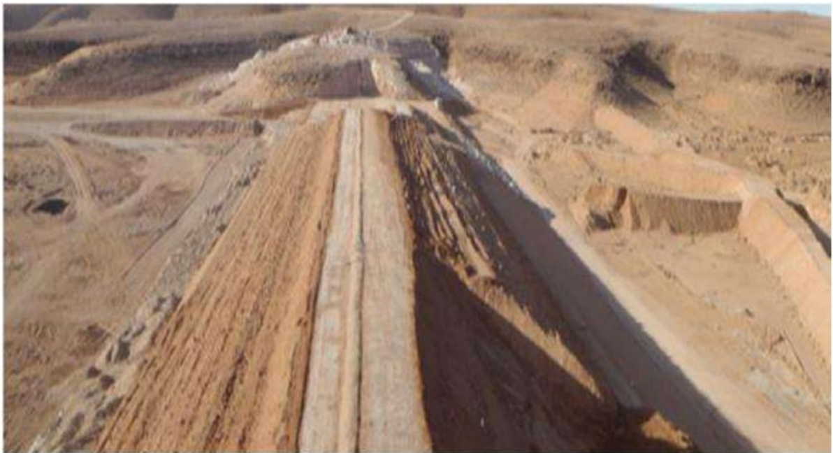
Photo IV.3 : photo du Barrage El-Haimeur
