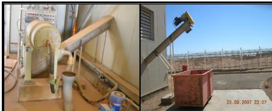
Figure II-24 : centrifugeuse et pelleuse.[44]
