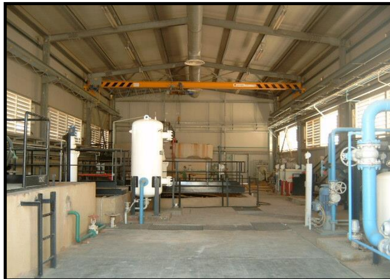
Figure II-17: station de déshuilage du champ de HBK.[44]
