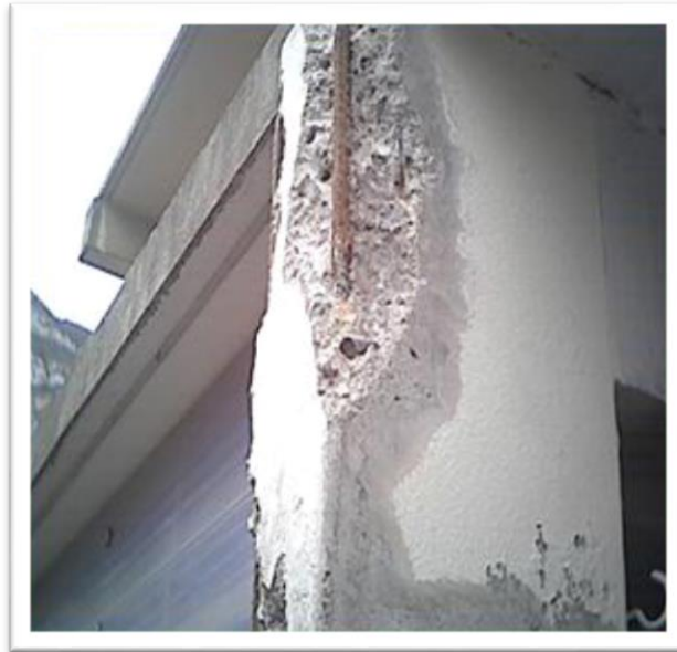
Figure I- 13. Dégradation des éléments d'un ouvrage par carbonatation.
