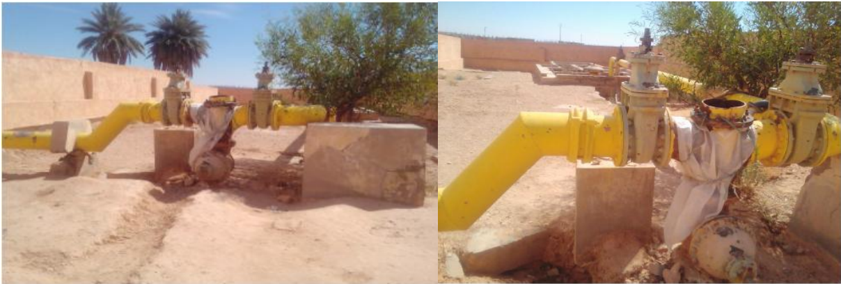
Figure 27: Tête de forage (rapport de fin sondage 1954)
