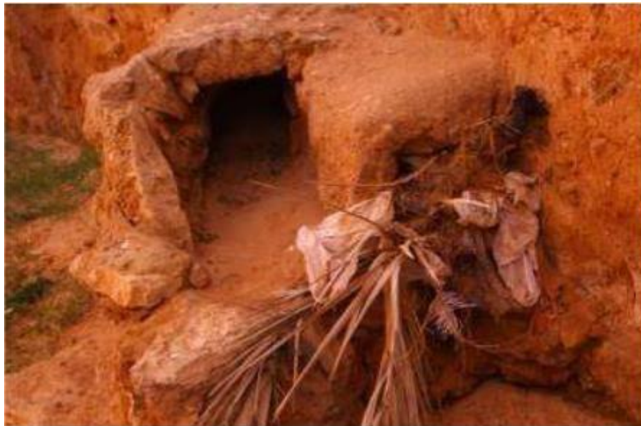
Figure III.26. Double koua bouchée par des débris lors de la dernière crue (Photo. Remini, 2019)
