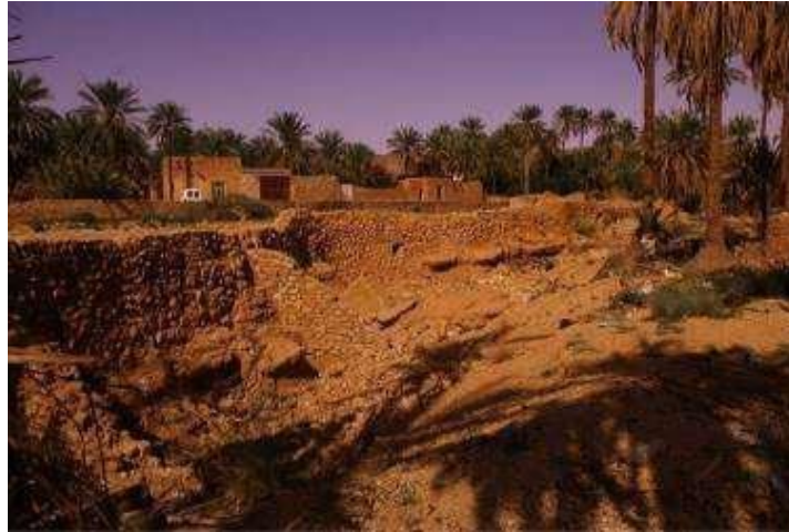
Figure III.11. Partie avale du Grand barrage Si Lekhel (Photo. Remini, 2019)
