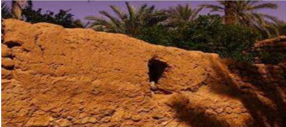
Figure III.35: Dispositif d'évacuation à 1 ouverture du surplus d'eau vers l'oued Metlili (Photo. Remini, 2019)
