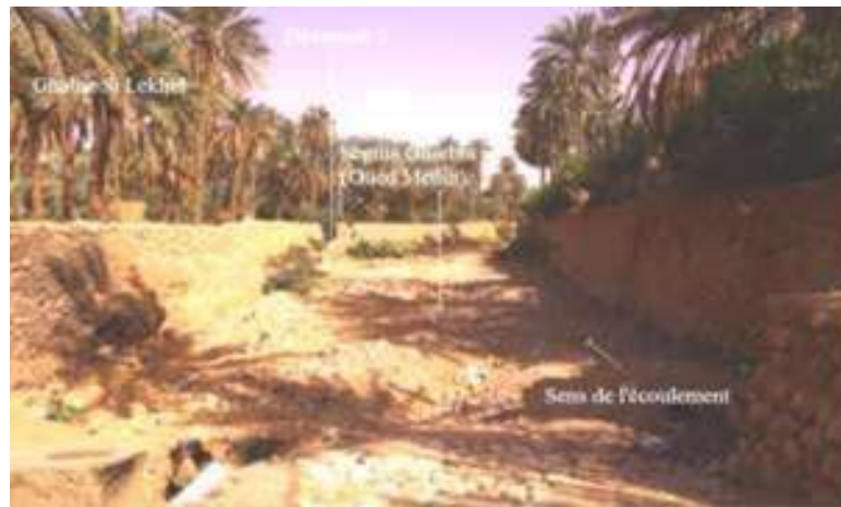
Figure III.49. Déversoir 3 pour évacuer le surplus vers l'oued Metlili (Photo. Remini, 2019)
