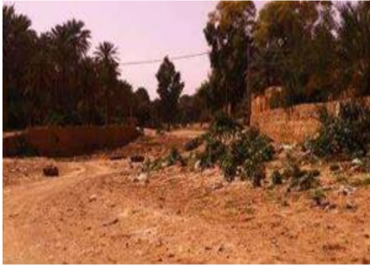
Figure III.50. Une vue de la galerie d'évacuation des eaux pluviales vers l'oued Metlili (Photo. Remini, 2019)
