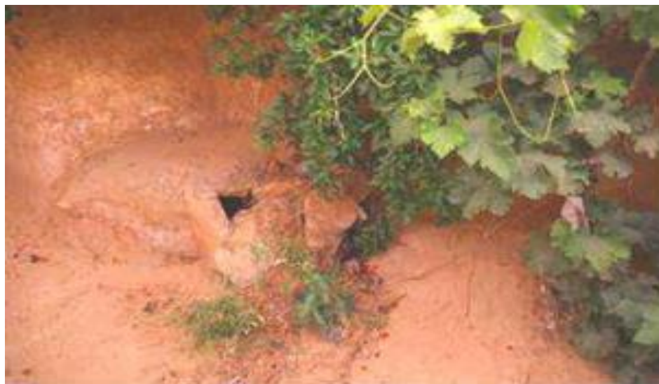
Figure III.27. Une koua bouchée par des blocs (Photo. Remini, 2019)
