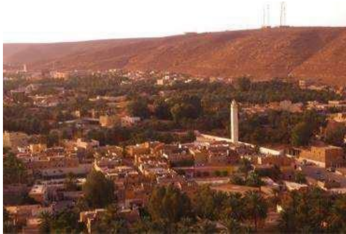
Figure III.4. Un aperçu sur la palmeraie de Metlili (Photo. Remini, 2019)
