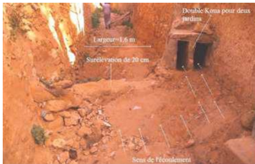
Figure III.24. Double koua (alimentant deux jardins consécutifs) située dans une seguia secondaire très dégradée et non entretenue (Photo. Remini, 2019)
