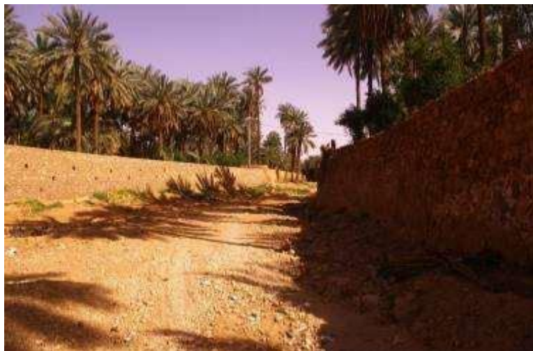
Figure III.13. Oued Metlili sur lequel ont été bâti les Ahbas (Photo. Remini, 2019)
