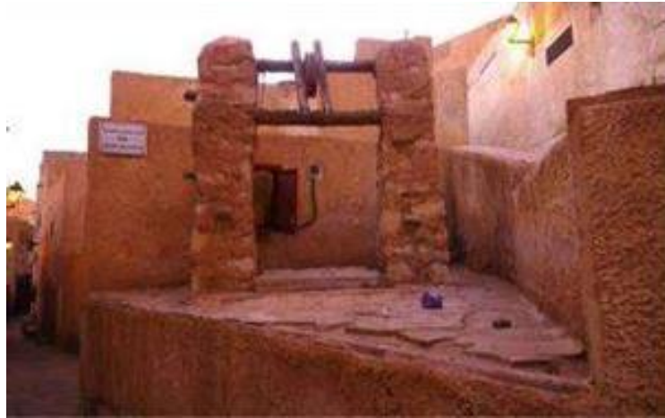
Figure III.37. Un des puits qui alimente le ksar de Metlili(Photo. Remini, 2019)
