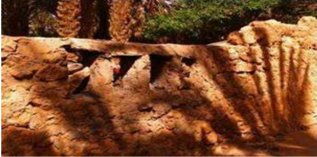
Figure III.33. Dispositif de 4 ouvertures d'évacuation du surplus d'eau vers l'oued Metlili (Photo. Remini, 2019)
