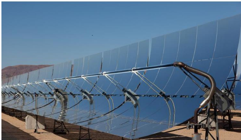
Figure I.7 : Capteur solaire thermique cylindro-parabolique
