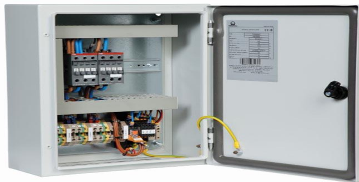
Figure II.43 : Coffret d'inverseur de source. [20]
