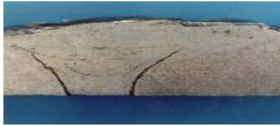
Figure IV.2 : Fissure à froid. [27]
