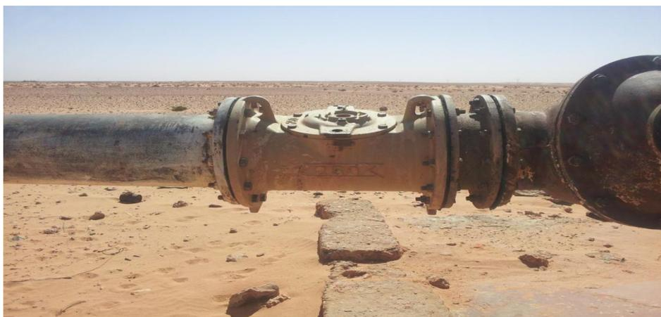
**PHOTO 16 : Conduite en acier de diamètre 250 mm liée le forage et cheminée de mise en charge**
