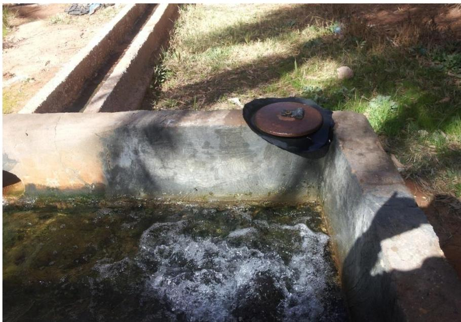
*Photo 05: Système d'évacuation les eaux d'irrigation excédentaires du périmètre N° 01*
