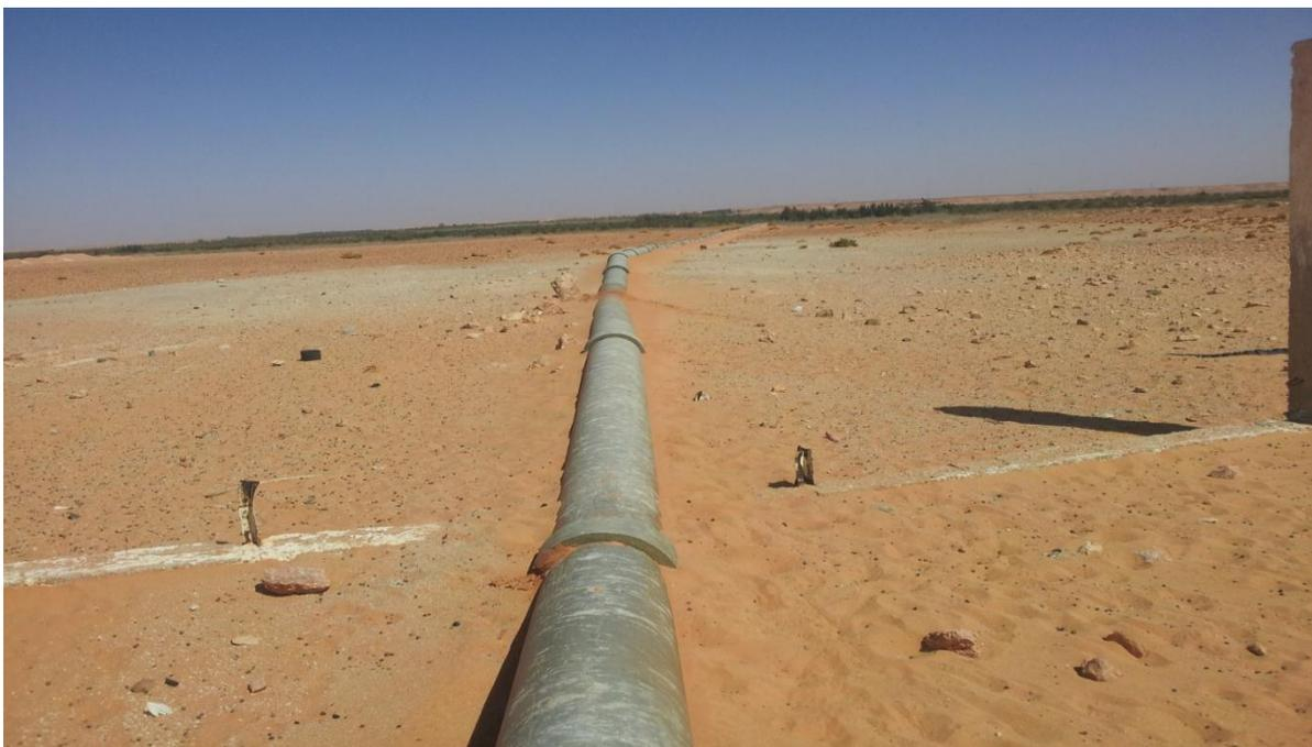
**PHOTO 17 : Conduite en amiante ciment posée sur le sol de diamètre de 400 mm**
