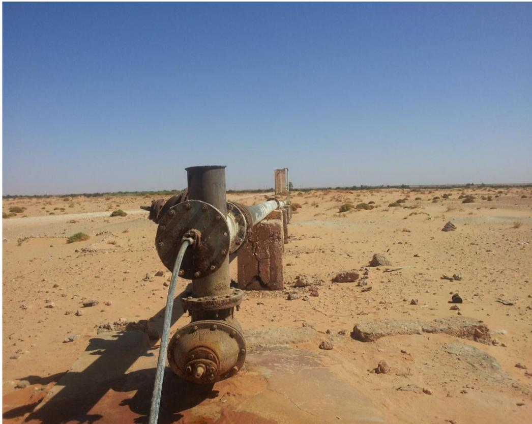
**Photo 15 : Le forage avec cheminée de mise en charge**
