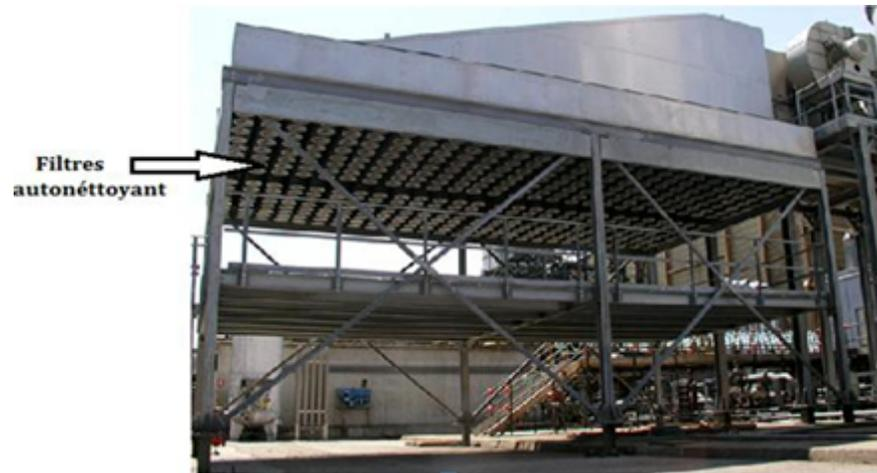
**Figure 8 : Filtre de type Autonettoyant.**
